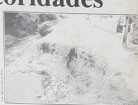
As laterais do rio estão desbarrancando e destruindo a passagem pela rua Manoel Ribas
