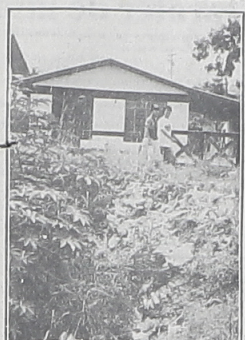
Polição no alto que serve como depósito de lixo
