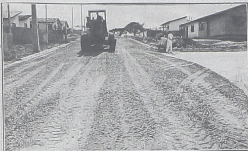
A pavimentação das ruas das moradias Bom Jesus: finalmente
