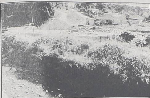
Galeria pluvial em construção para o rio Pedreira
