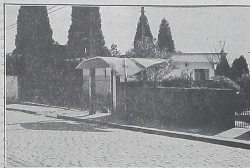
Abrigos em péssimo estado de conservação
