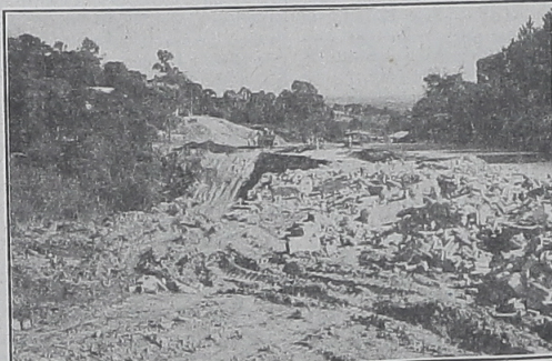
Caminhões e homens estão preparando o terreno que receberá pavimentação asfáltica patrocinada por empresários locais
