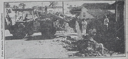
Obras de reparação na Domingos Cordeiro finalmente estão em andamento
