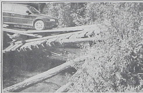
Ponte sobre o rio Santana: situação difícil
