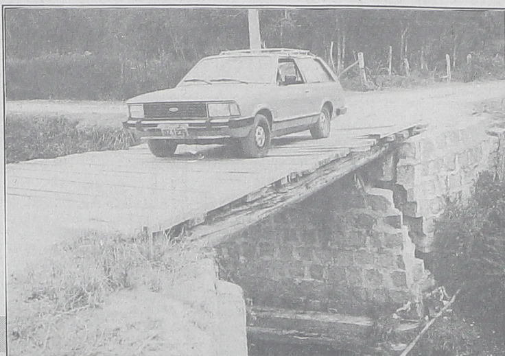
Ponte condenada desde março ainda serve para a travessia de automóveis. Ao lado: as bases da ponte estão prestes a cair
