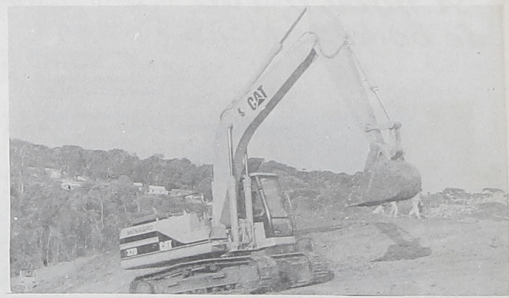
As máquinas estão encontrando muitas dificuldades, devido à topografia do terreno
