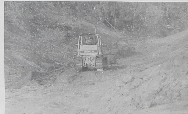
A terraplenagem da área está na parte dos fundos do terreno
