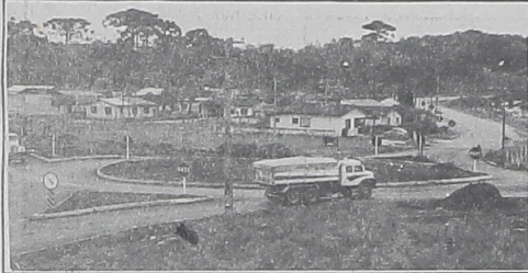
Rotatória: obra preventiva de acidentes
