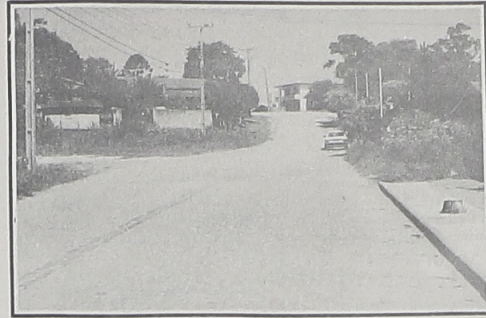
Ruas da Vila de Lurdes: buracos, falta de pavimentação, poeira e muitas promessas não cumpridas.
