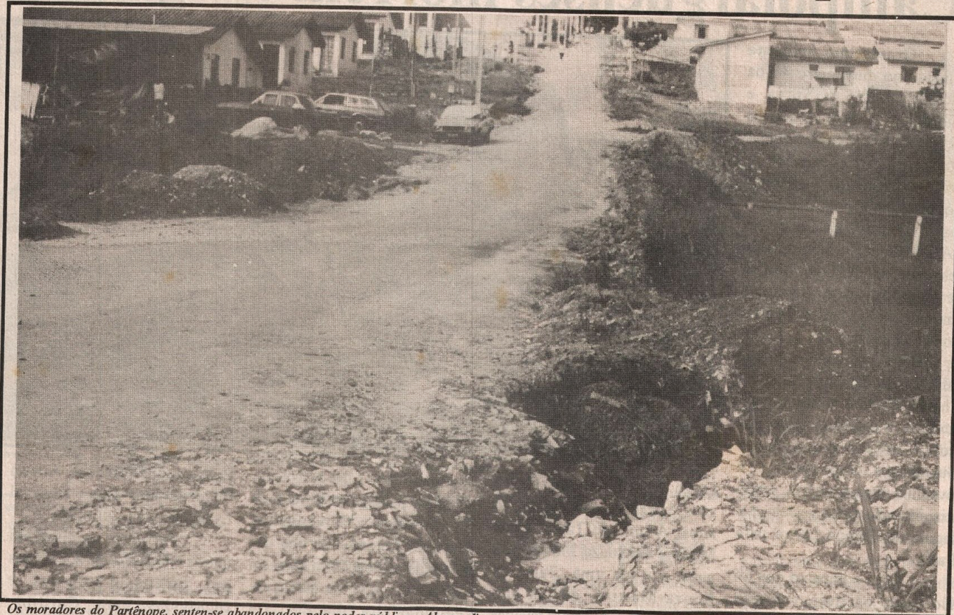
Os moradores do Partênope, sentem-se abandonados pelo poder público. Alguns dizem que a promessa de melhoria foi só "promessa de campanha". Os buracos...
