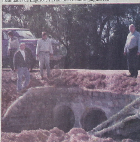
Prefeito Edmundo Bora, fiscalizando as obras em Balsa Nova
