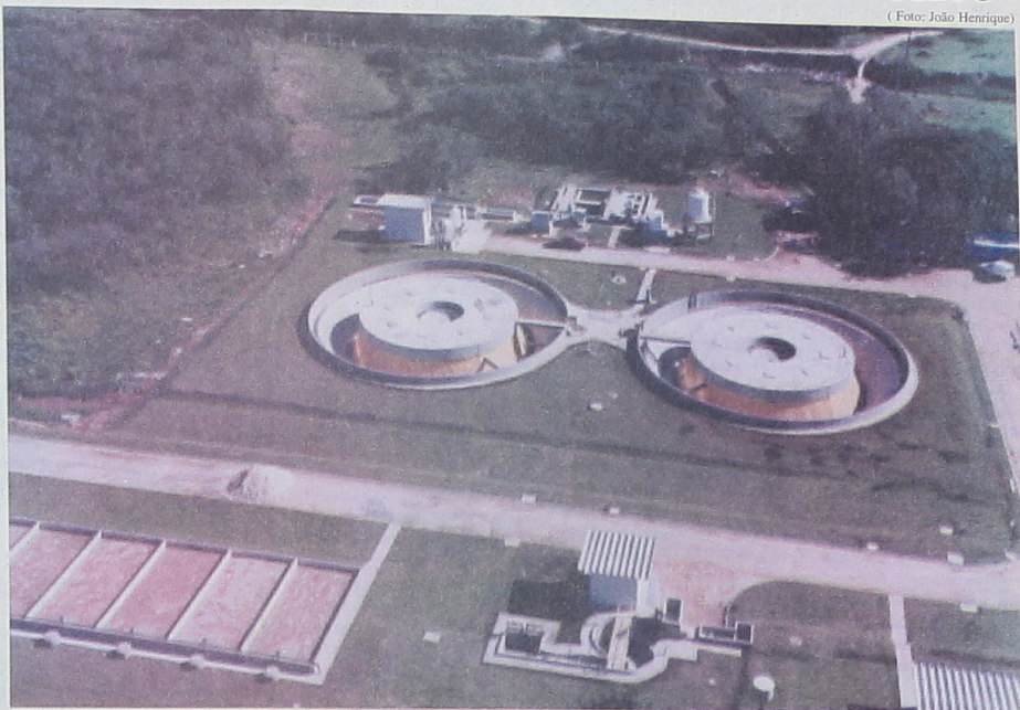
A Estação de Tratamento de Esgoto Cambuí, localizada no Botiatuva, em Campo Largo, já atende 20 mil campolargueses
