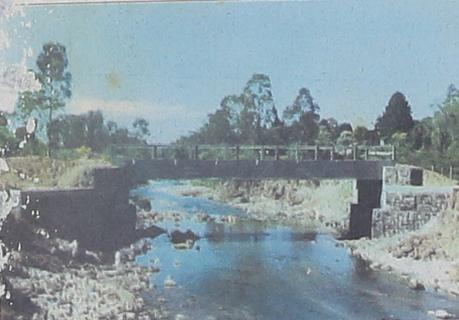
Duas novas pontes sobre o rio Cambuí, na região do Botiatuva, serão inauguradas no próximo dia 12. Elas foram construídas para substituir as que foram arrancadas durante um forte temporal, no final do ano passado. As pontes, construídas em parceria com o Departamento de Estradas de Rodagem (DER), são de concreto, têm 16 metros de comprimento e darão acesso a regiões como o Jardim Tropical, Vila dos Lopes e Estrada da Ratada. **Página 5A.**
